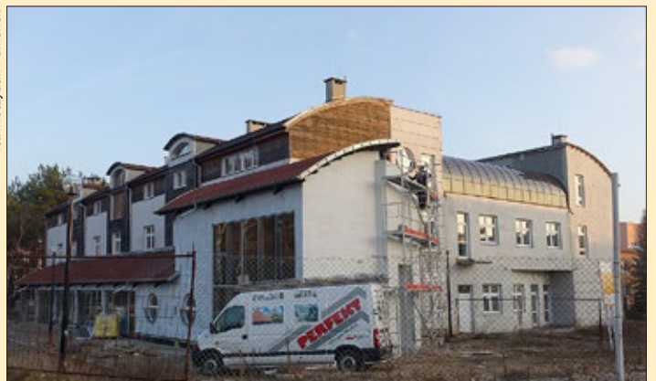
12.2014 - kończą się powoli prace na budowie Domu Jubileuszowego św. Jana Pawła II. Aktualnie wykonywane jest główne wejście do budynku od strony ul. Alfonsa Lickerskiego, prace wykończeniowe - szczególnie ocieplanie i Klimatyzacja
