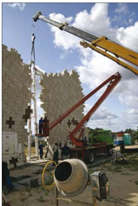
13. sierpnia 2009 - na XII Stacji ukończono konstrukcję i nadszedł moment instalacji krzyża
