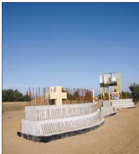
11. października 2008 - fundamenty XII Stacji zostały ukończone i przyszedł czas stawiania konstrukcji
