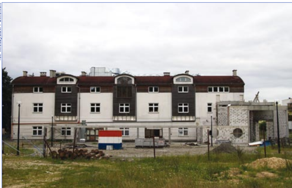
Na budowie Domu Jubileuszowego w lipcu 2013 powstają: brama "Trzeciego Tysiąclecia" i mury uzupełniające część restauracyjną
