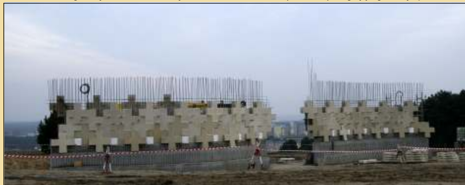
8.03.2009 - stan prac na budowie XII Stacji Kalwarii Bydgoskiej
