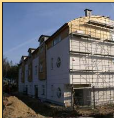
18.02.2007 - na budowie Domu Jubileuszowego
