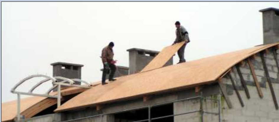
13.12.2004 - prace na dachu Domu Jubileuszowego, fot. "Mała"
