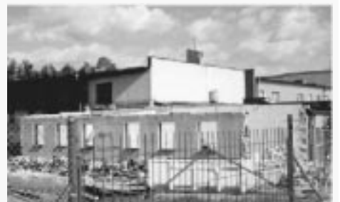
Sierpień 2001 - na budowie domu jubileuszowego
